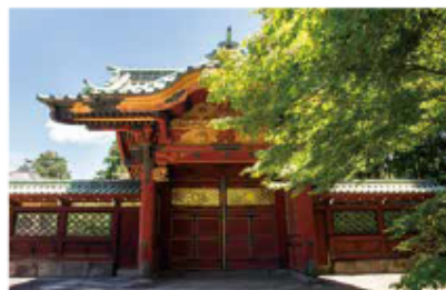
常楽院殿材額門(重文)。第5代将軍綱吉公の廟所に建つ門。第2次大戦の空襲で大きな被害を受けた徳川家霊廟の貴重な遺構の一つ。
